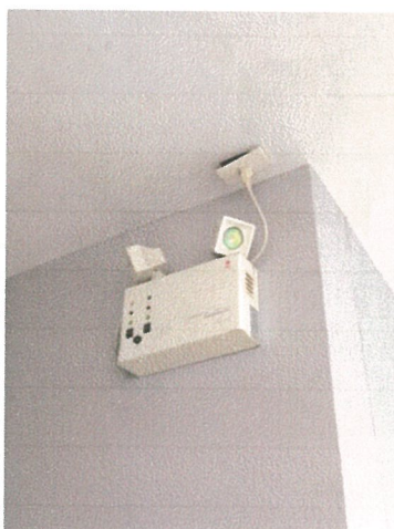
รูปภาพที่ 2.27 ไฟส่องสว่างฉุกเฉิน
