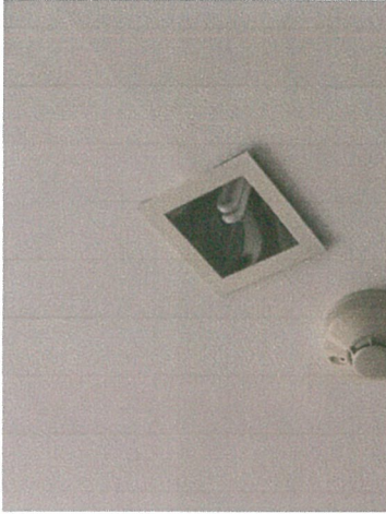
รูปภาพที่ 2.14 หลอดไฟ LED
