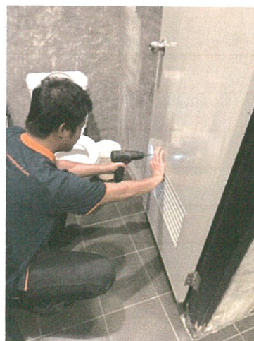
รูปภาพที่ 2.40 การตรวจสอบและอุดรอยรั่วตามผนัง ฝ้าเพดาน ประตู
