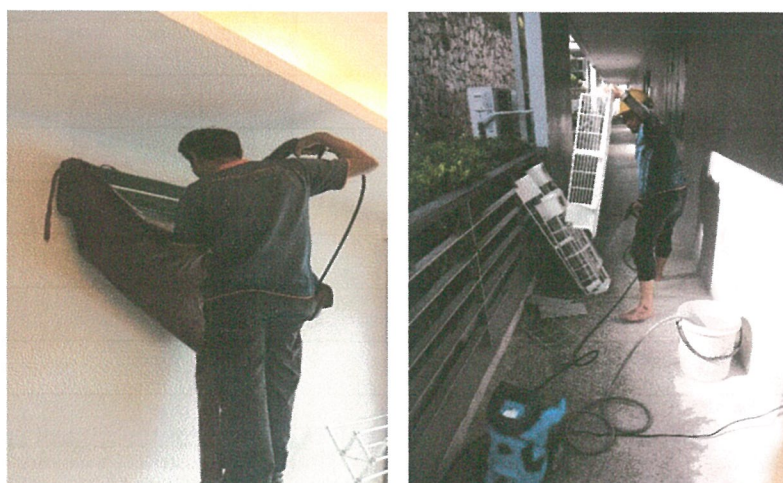
รูปภาพที่ 2.5 การล้างทำความสะอาดเครื่องปรับอากาศ
