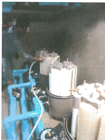
รูปภาพที่ 2.38 เครื่องกรองน้ำ (สระ)
